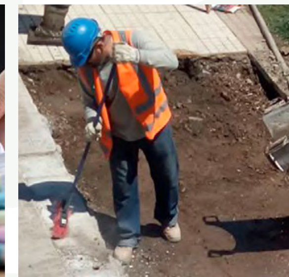
Ejecución de obras
