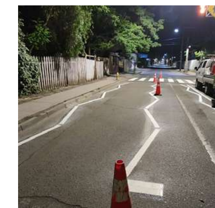
Obras de señalización y demarcación
